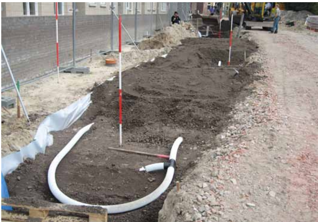
Boomstraat met granulaat in een wortelstraat.
