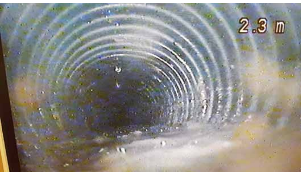
Dit ziet Ton de Kroon op zijn beeldscherm als de camera de drainage in gaat.
