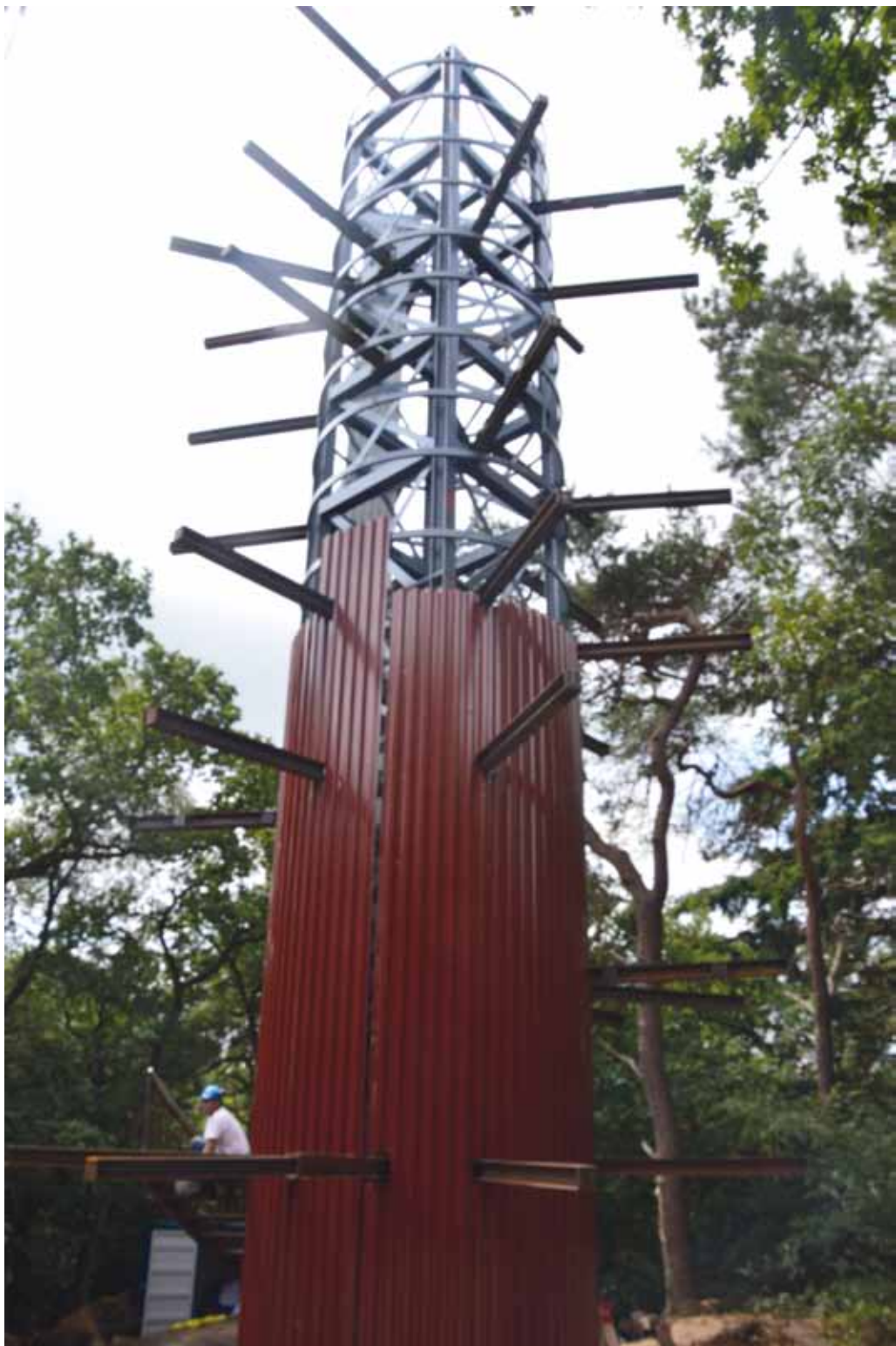
Aanleg uitkijktoren Bosberg.
