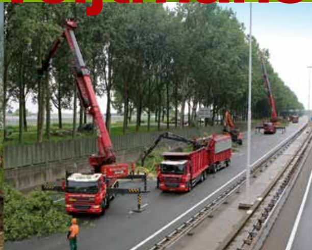
Werkzaamheden aan de A20 bij Nieuwerkerk aan den IJssel
