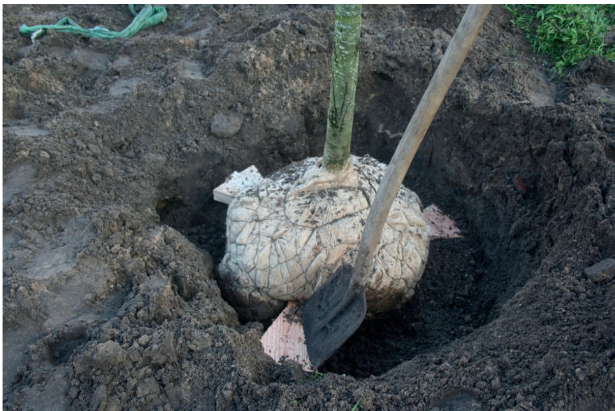
Kluitverankering is er in allerlei soorten en maten. Hier de Arbretio Boomplantwiggen van Loohorst. Speciaal voor planten in granulaat.
