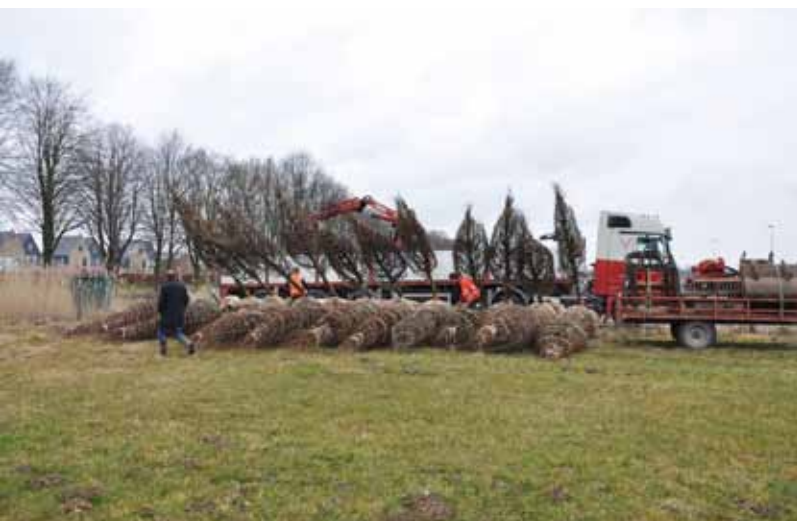
Het verleggen en herstellen van de lindelaan.
