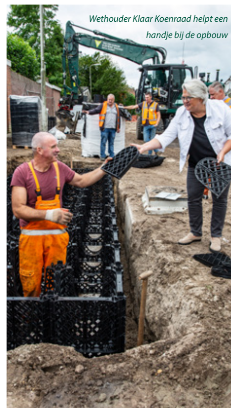
JSTN. AquaMulti Box als waterbuffer onder het RootSpace-systeem
