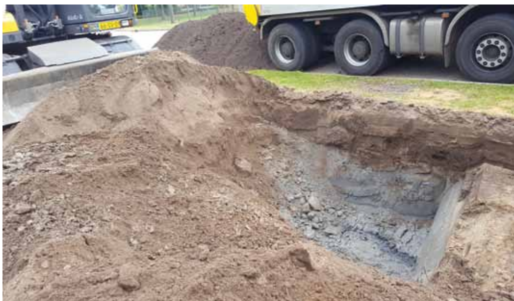
Maar liefst 30 kuub leemlaag werd met een kraan verwijderd.
