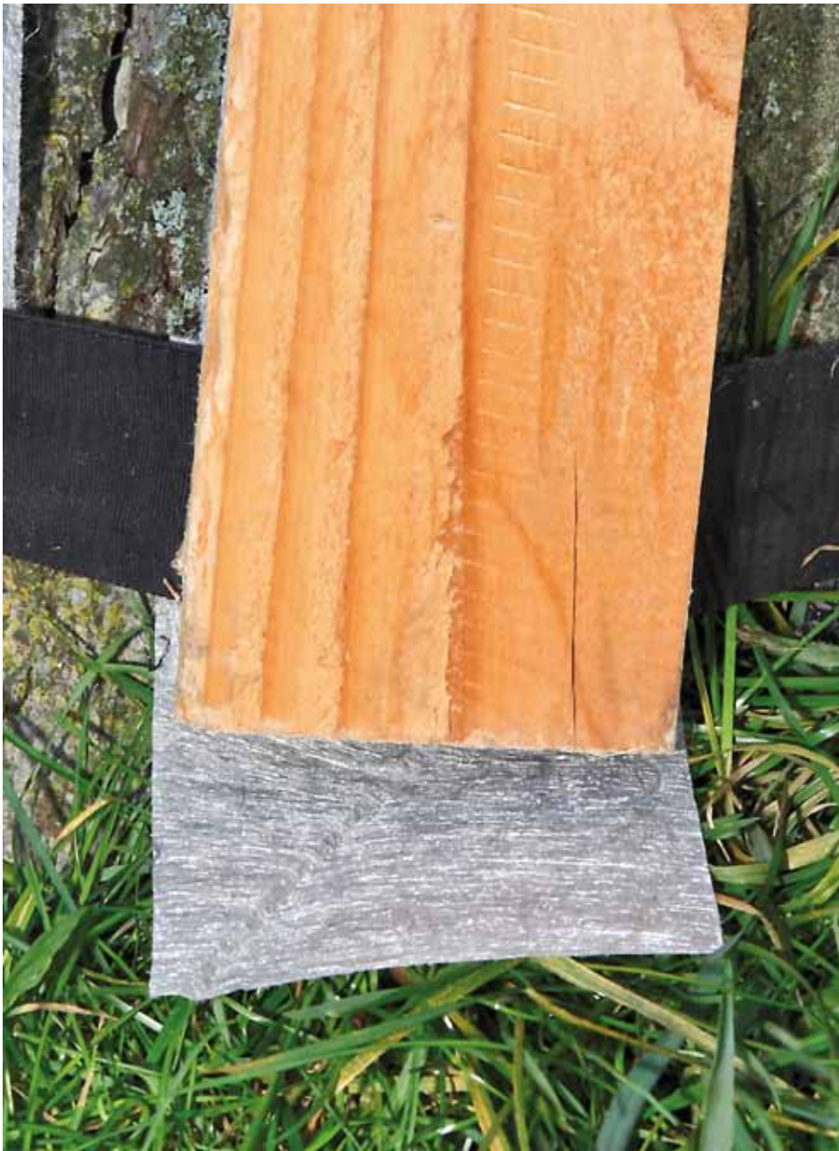
De douglashouten planken zijn aan elkaar bevestigd met autogordelband, die men kan doorsnijden als de stamdiameter kleiner is.
