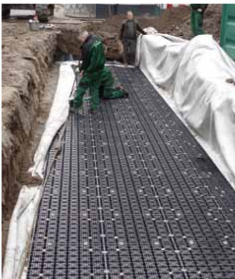
Hattem - Passief irrigatiesysteem
