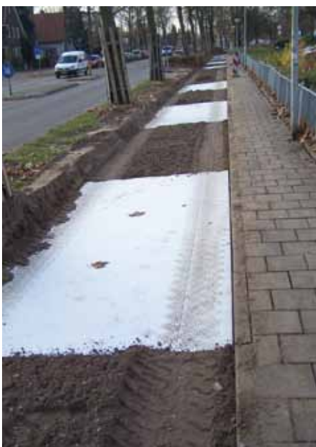
Asfalt op Permavoid
