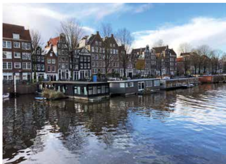
Deze woonboten zijn tijdelijk verplaatst om het werk aan de kade waar ze normaal liggen mogelijk te maken.
