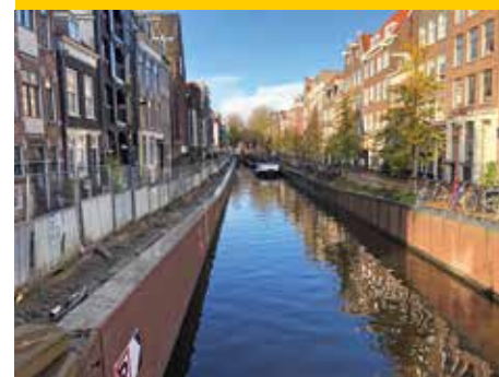
Aan deze gracht is rechts de kademuur al gerestaureerd en voorzien van nieuwe bomen.
