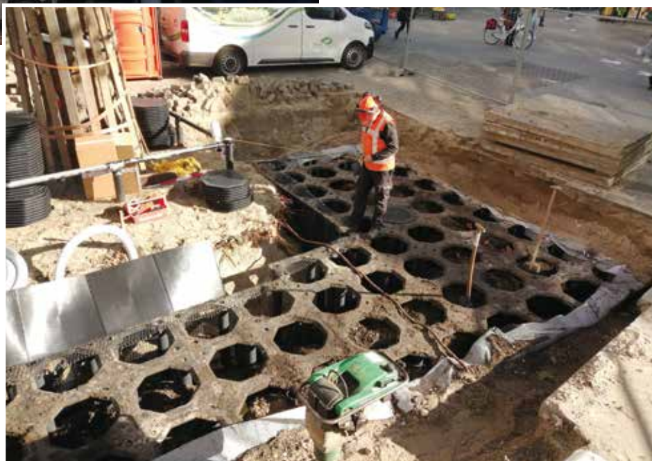
Installatie van het TreeParker-boombunkersysteem
