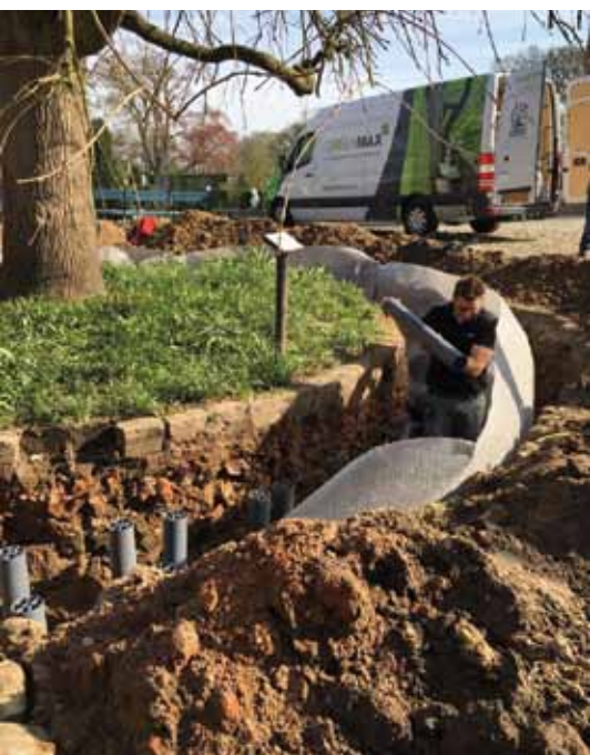
Aanleg van het boombunkersysteem.
