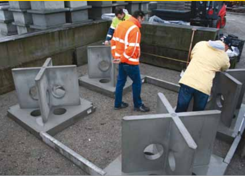
Aanleg van het Treebox HP-systeem. Lateien tussen de kruizen.
