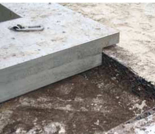
Aangepaste betonnen afdekking tegen en over de Permavoid-wand.
