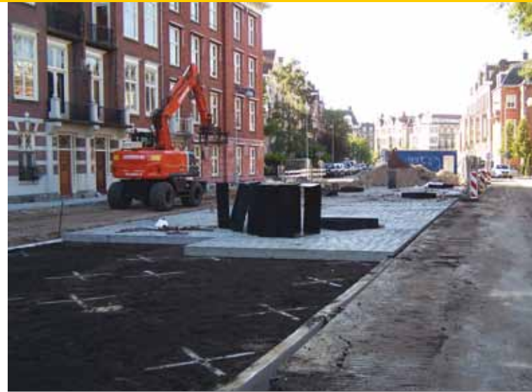
Aanleg Treebox HP-systeem, einde van de eerste fase. Johannes Vermeerstraat, Amsterdam.
