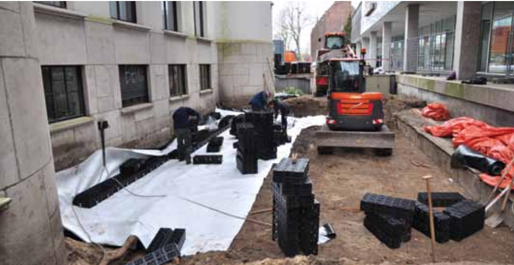
De groeiplaats tussen de twee torens is verbeterd. Het maaiveld wordt afgedekt met Permavoid-kralen om verdichting van de bodem te voorkomen en deze van voldoende zuurstof en water te voorzien.
