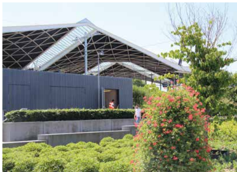
Station Tilburg onderging een flinke metamorfose, waarbij veel ruimte is voor groen.
