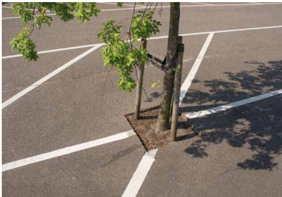
Asfalt gereed, gat erin en boom erin. Een uitgesproken klimaatboom zal het hier evenmin fijn vinden.
