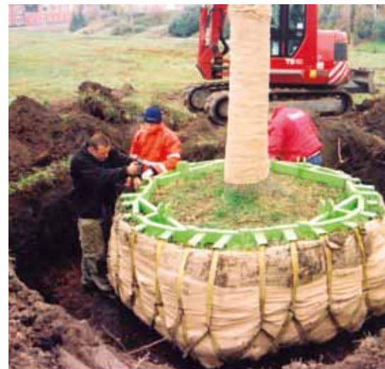
Aanbrengen Newman frame Meppel
