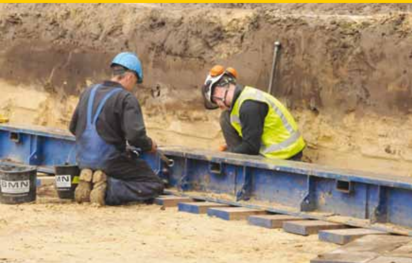
Het stellen van de rails waarover de boom verplaatst wordt.
