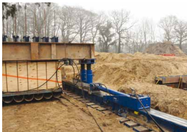
Twee van deze vijzels met een uitslag van 1,50 meter drukken de boom naar zijn uiteindelijke locatie.
