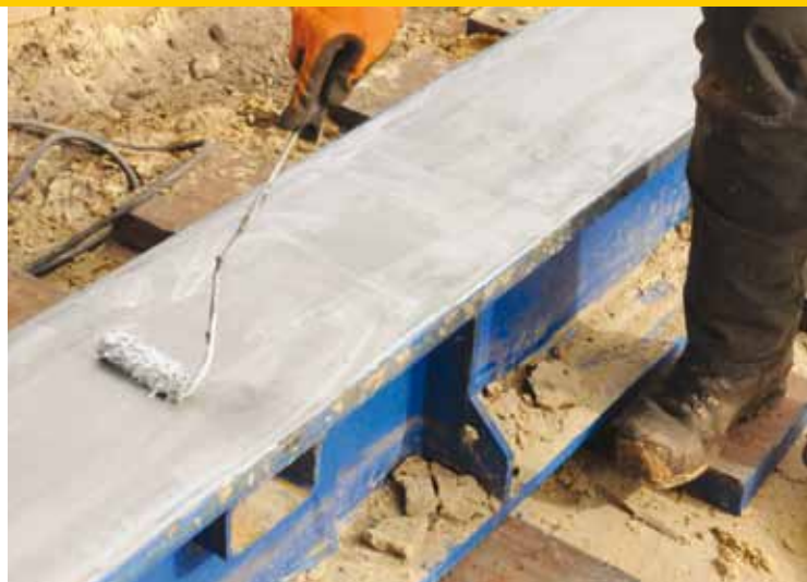
Rail wordt met siliconenvet ingesmeerd, zodat het object beter schuift.
