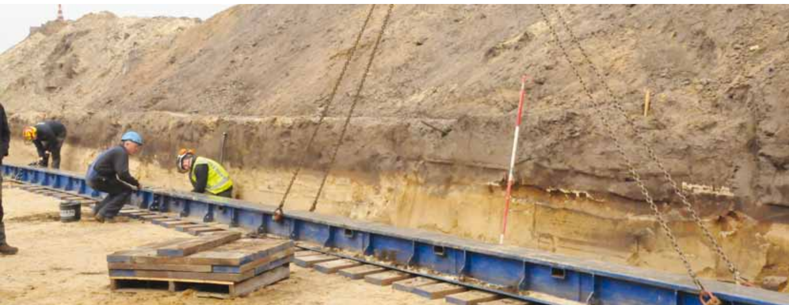
Het stellen van de rails waarover de boom verplaatst wordt.
