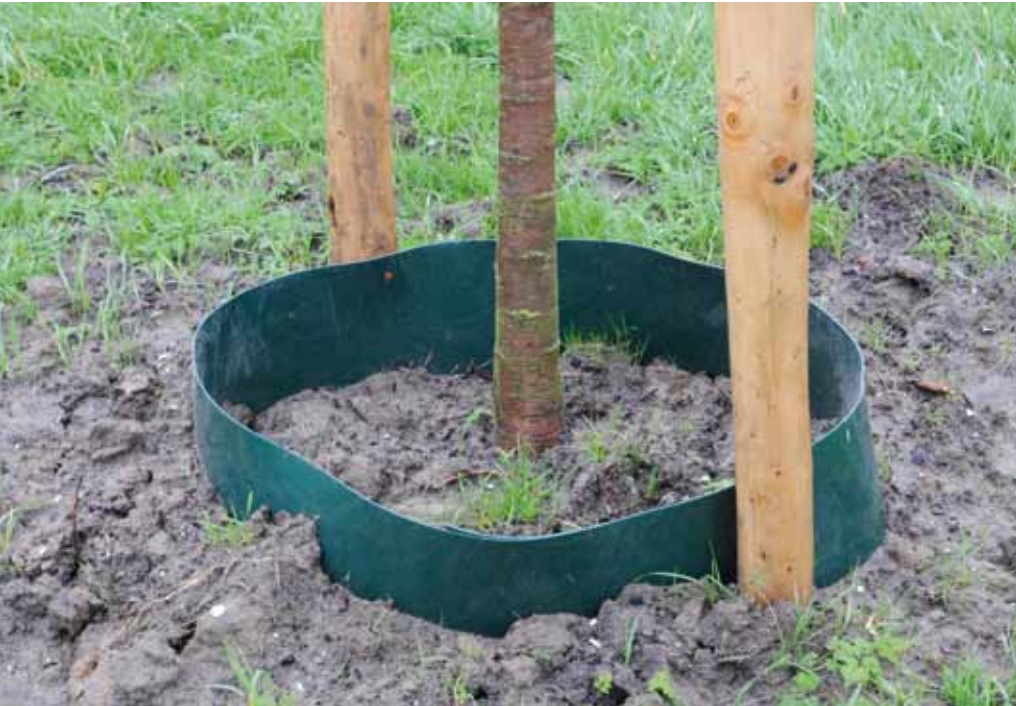
De bomen zijn bovengronds verankerd met twee palen met een gietrand, om in de eerste jaren van het groeiseizoen voldoende watervoorziening te garanderen.
