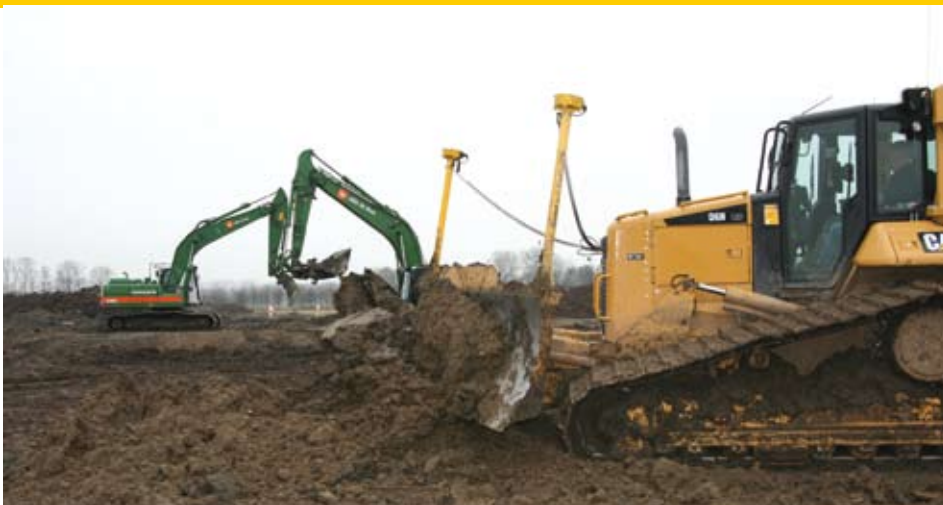
Uitvoering werkzaamheden met GPS op de shovels.
